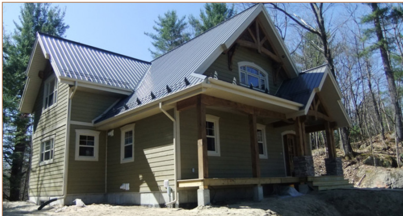
Maison de style aire ouverte et spacieux tout avec mézzanine
